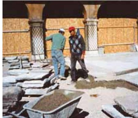
L'intervento è stato eseguito con la rimozione manuale delle pietre di pavimentazione e l'accatastamento del materiale riutilizzabile in cantiere. Le pietre ancora in buono stato con limitata rottura sulla superficie sono state ripassate e reimpiegate mediante tagli opportuni in relazione alle misure variabili della tessitura di pavimentazione a correre esistente.
